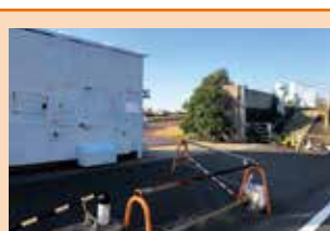
旧江戸川堤防耐震化排水樋管工事
