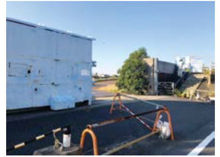
▲旧江戸川堤防耐震化排水樋管工事
