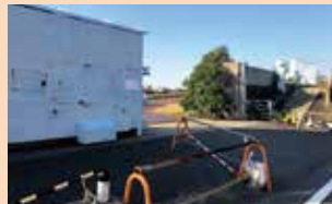
旧江戸川堤防耐震化排水樋管工事
